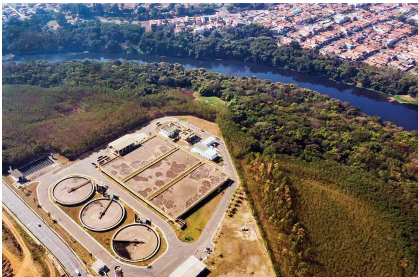
Estação de Tratamento de Esgoto (ETE) Ponte do Caixão, localizada à margem do rio Piracicaba (SP)
